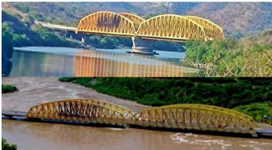
CD. LÁZARO CÁRDENAS, MICH.- Las lluvias torrenciales causadas por el huracán "John" han generado una crecida significativa en la Presa de Infiernillo; la infraestructura del puente se encuentra a pocos metros de ser alcanzada por el río.
