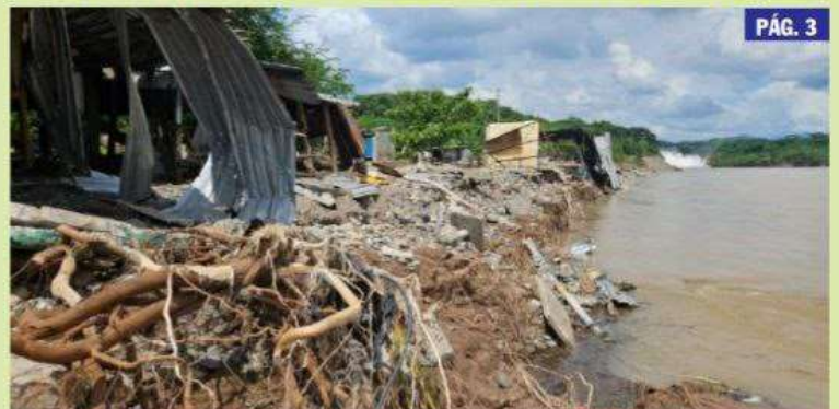
CD. LÁZARO CÁRDENAS, MICH.- Las enramadas de la tenencia de Las Guacamayas quedaron devastadas tras el impacto del huracán "John", dejando a los comerciantes en una situación crítica.
