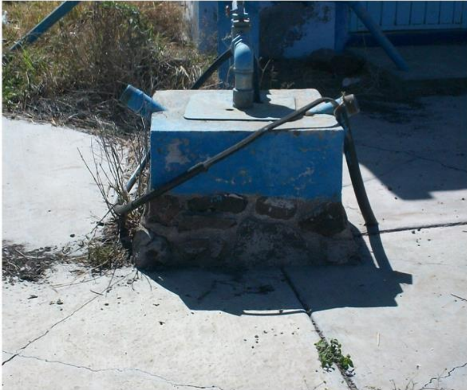
Imagen 50: Lugar: Puerto de Cojumatlán, Mich. Vista del agrietamiento en firmes de concreto en pozo de bombeo por hundimientos
